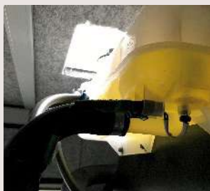
ALLARME LIVELLO LIQUIDO REFRIGERANTE WATER LEVEL ALARM
