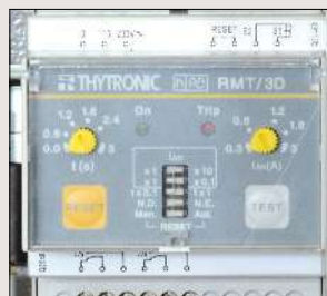
INTERRUTTORE DIFFERENZIALE EARTH FAULT BREAKER
