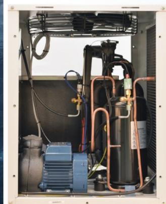
La pannellatura e la struttura di tipo autoportante sono completamente realizzate in acciaio ed esternamente verniciate a polveri, rendendo la gamma QBE idoneo ad installazioni esterne e resistente agli agenti atmosferici. Tutti gli elementi di fissaggio sono in acciaio inox o elettro-zincati. I pannelli facilmente rimovibili permettono l'accesso all'interno dell'unità per le operazioni di manutenzione e riparazione.
